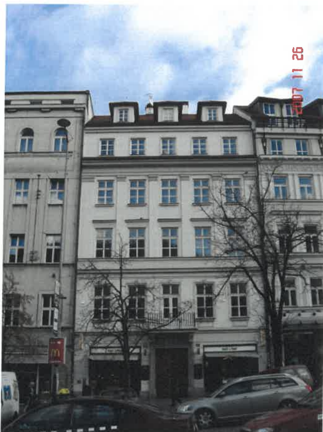
Praha 1, Václavské náměstí 1282/51, byt v 1. patře dvorní části objektu
