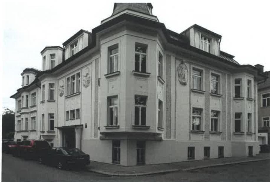
Fotodokumentace – Na Baště sv. Jiří 258/7, část prostor v suterénu objektu
